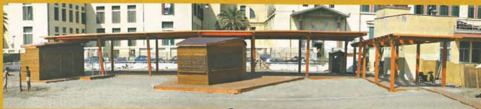
Veduta d'insieme dal mare dell'area ex Colonia Vittorio Emanuele
